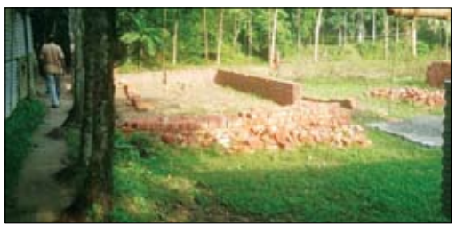
중지된 탕가일 교회 건축 현장
