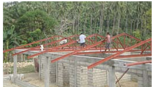
증축 중인 건물
