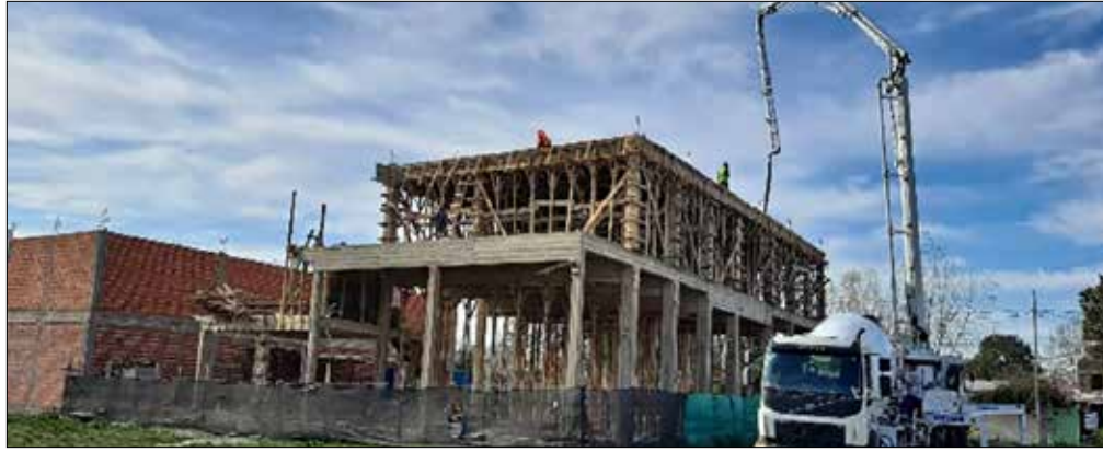
아가페 교회 건축 현장 ( 콘크리트 타설과 작업하는 인부들의 모습 )
